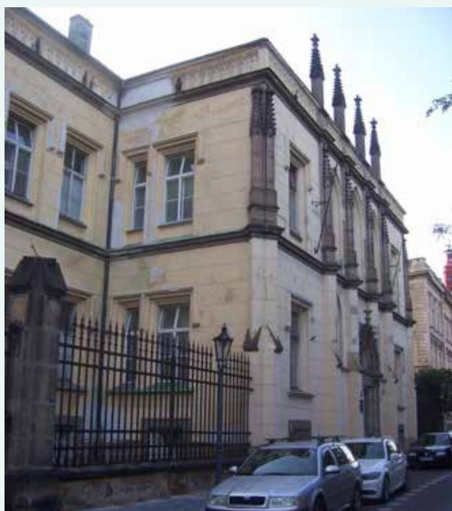
Obr. 27. Ke Karlovu 458/4 – Kupecká nemocnice (od roku 1862)
