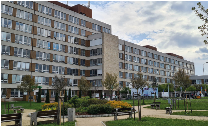
Pavilon F Fakultní nemocnice Plzeň-Lochotín, kde jsou v 7. a 8. patře ambulance jednotlivých oddělení Stomatologické kliniky a v 6. patře je lůžkové oddělení.
