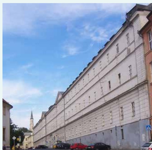
Obr. 12. U nemocnice 499/2 – Všeobecná nemocnice (1790–dosud)
