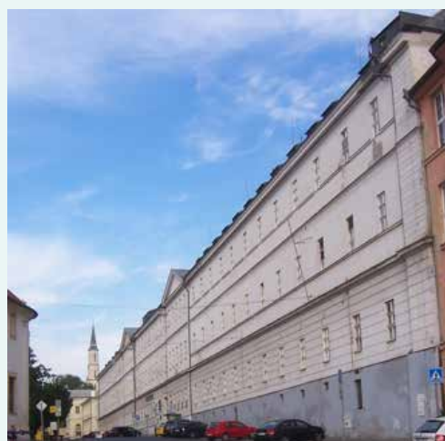
Obr. 12. U nemocnice 499/2 – Všeobecná nemocnice (1790–dosud)
