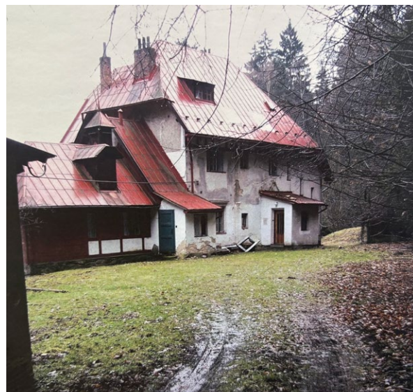
Obr. 4 Pifflova vila v Lanškrouně – stav před rekonstrukcí
