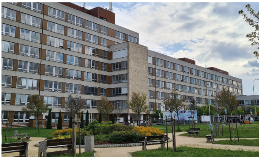
Pavilon F Fakultní nemocnice Plzeň-Lochotín, kde jsou v 7. a 8. patře ambulance jednotlivých oddělení Stomatologické kliniky a v 6. patře je lůžkové oddělení.
