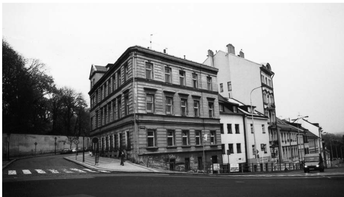
Obr. 4 Dům na křižovatce mezi ulicemi Viničná a Benátská, první sídlo zubní kliniky
