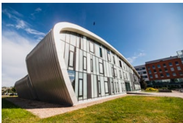
Obr. 6 Výukové centrum LF UK v areálu FNHK
